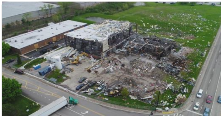
Фото после взрыва на заводе AB Specialty Silicones (Reference CSB report No. 2019-03-I-IL)
