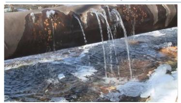
Компания решила прекратить производство химического продукта. Одним из исходных материалов был токсичный и коррозионно-активный трихлорид фосфора (PCI3). Линии к резервуару для хранения и в технологической зоне были очищены от PCI3. Несколько лет спустя оператор обнаружил утечку на открытом воздухе. Расследование показало, что утечка исходила из «пустой» линии PCI3. Никто не пострадал, и разлив был локализован.
