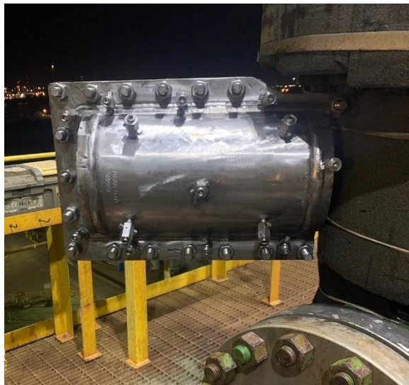
Фигура 1. Временна Тръбна скоба над клапан, който е изтичал
