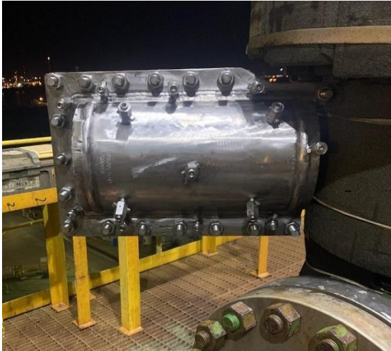
Obrázek 1: Dočasná opravná objímka přes netěsnou armaturu
