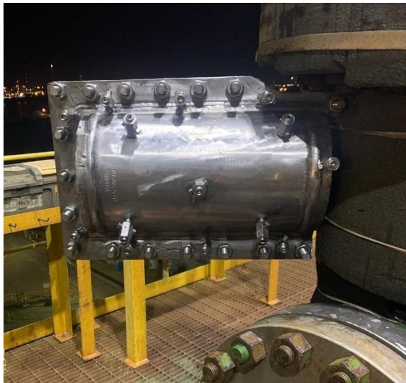
شکل ۱. یک بست موقت (Clamp) بر روی خط لوله در بالای شیر که نشستی داشته است.
