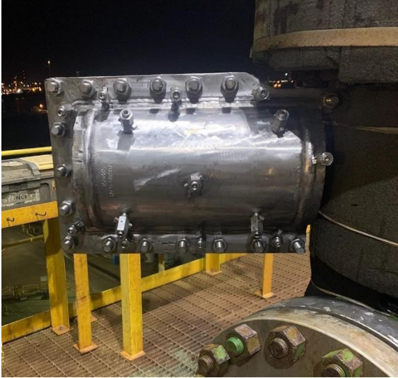
תמונה מס' 1 חבק זמני על צינור ומגוף שדלפו
