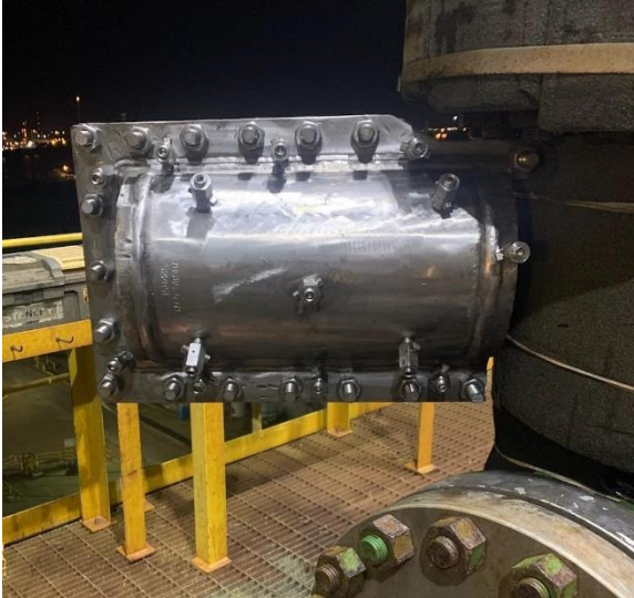
รูปที่ 1. clamp ที่ใช้รัดท่อชั่วคราวครอบตัววาล์วที่กำลังรั่ว
