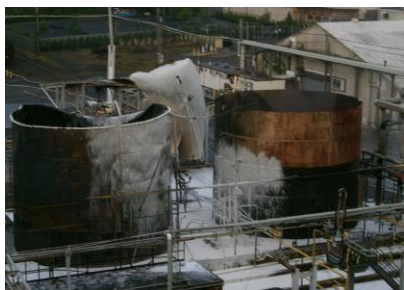
شکل ۲: مخازن بعد از آتش سوزی
