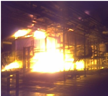
Foto 1. Pożar zbiornika po uderzeniu pioruna
