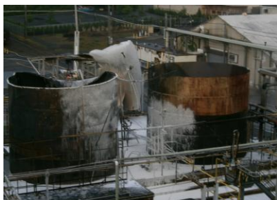
Figura 2. Tanques após incêndio
