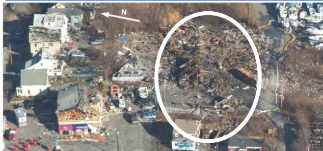
Obrázek 1: Výrobní barev poškozená výbuchem
