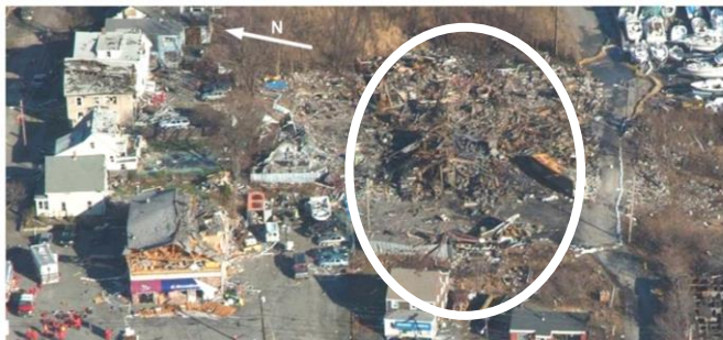
Afbeelding 1 verffabriek na de explosie
