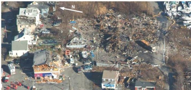
Abbildung 2 – Betrieb nach der Explosion
