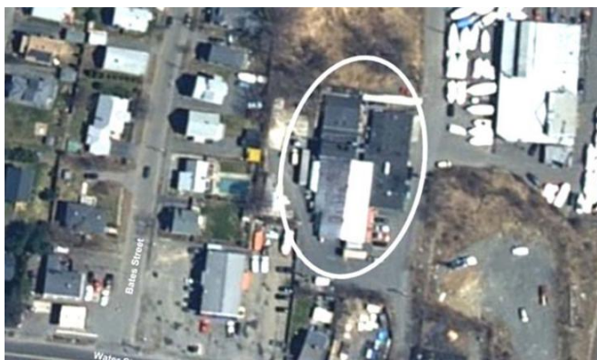
Figura 2: Fábrica de tintas antes da explosão
