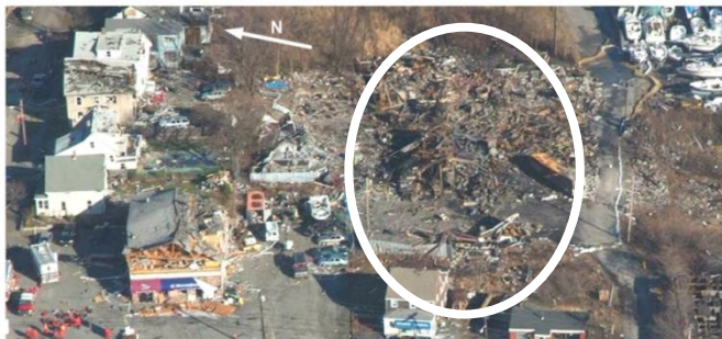
Figura 1: Danos da explosão na fábrica de tintas
