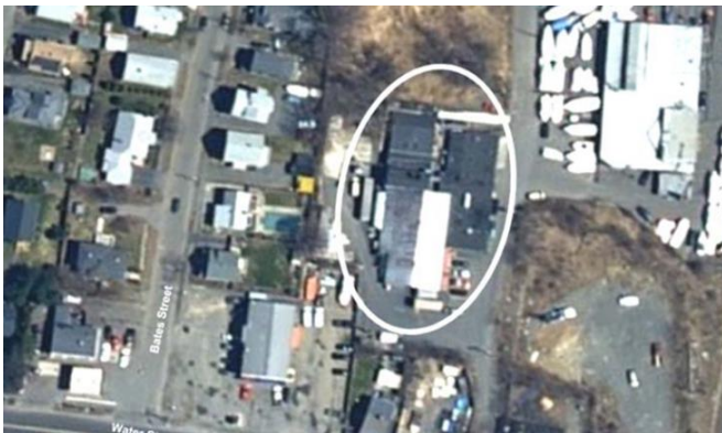
Figura 2 Fábrica de pinturas antes de la explosión
