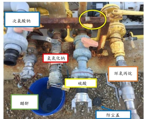
图 1: MCPI工厂内连接到化学品贮罐的管道。金属架上有硫酸加注管道的挂锁（见黄圈）。地面上有次氯酸钠防尘盖。（参见CSB报告2017-01-I-KS）
