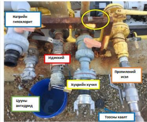
Зураг 1: MCPi компанийн үйлдвэрт байрлах химийн бодисын танкуудын холболт – Хүхрийн хүчил дүүргэх шугамын цоож (дугуйлсан) төмөр хүрээнд дээр байна. Натрийн гипохлоритын тоосны хаалт газар дээр байна. (Эх сурвалж: CSB тайлан 2017-01-I-KS)
