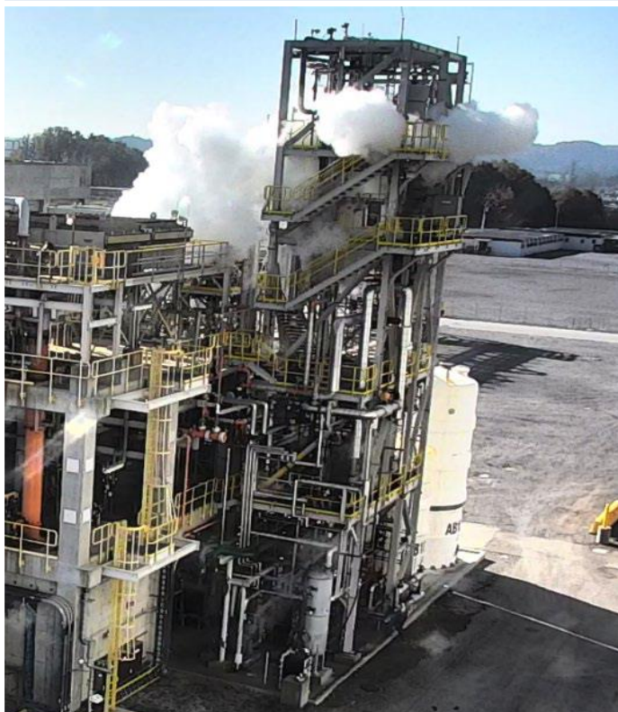
Fot. 1. Podest, na którym nastąpiło uwolnienie. 15 sekund później konstrukcja została objęta przez chmurę (Źródło: raport CSB No. 2021-01-I-TN)
