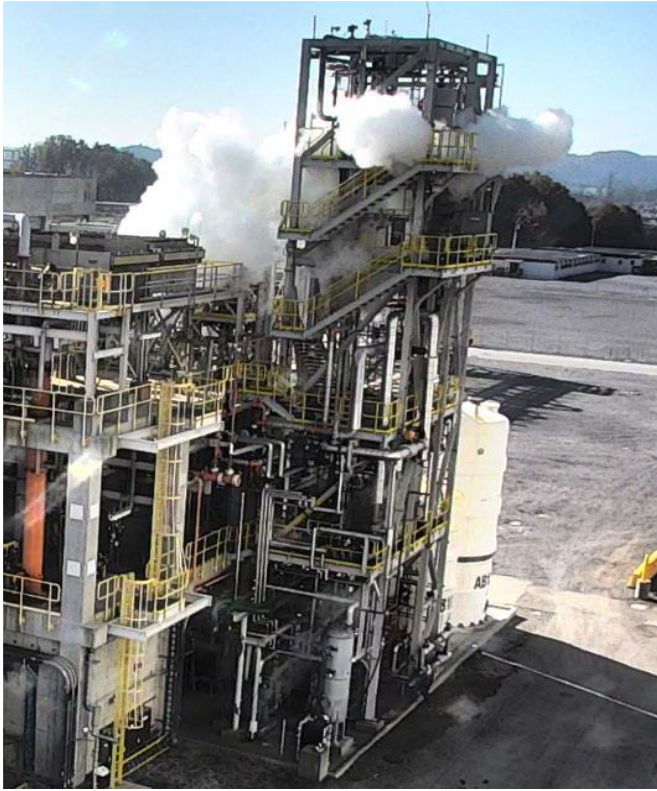
Hình 1. Sân thao tác nơi xảy ra sự cố rò rỉ. 15 giây sau, toàn bộ kết cấu bị bao phủ bởi đám mây khí. (Tham khảo báo cáo CSB số. 2021-01-I-TN)
