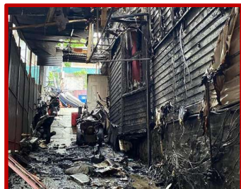
1. ábra: Lítium-ion akkumulátor tűz által okozott épületkár
