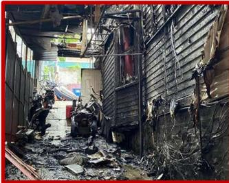
그림 1: 리튬이온 배터리 화재로 훼손된 건물.
