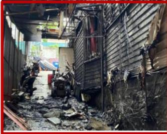
Figura 1: Danos em edifícios causados por um incêndio numa bateria de íons de lítio.
