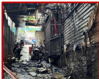
Fig. 1: Skada på byggnader orsakade av brand i ett litiumbatteri.
