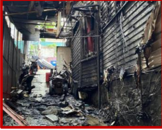
Şekil 1: Lityum iyon pil yangınının binalarda neden olduğu hasar.
