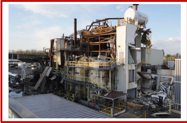
Figuur 1. Die hars reaktor gebou na die interne ontploffing (Bron: CSB verslag No. 2021-04-I-OH)
