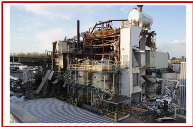
Фигура 1. Цехът за производство на смола след експлозията в него (Източник: доклад на CSB № 2021-04-I-OH)
