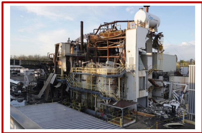
Obrázek 1. Stavba výroby pryskyřice po vnitřní explozi (Zdroj: Zpráva CSB č. 2021-04-I-OH)
