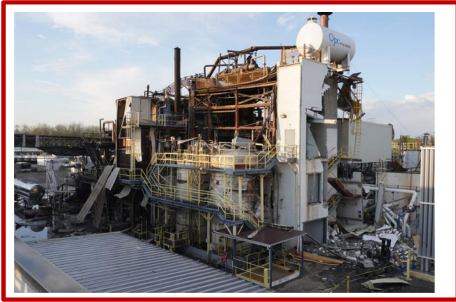
Figur 1. Resinbygningen efter den interne explosion (Kilde: CSB rapport No. 2021-04-I-OH)
