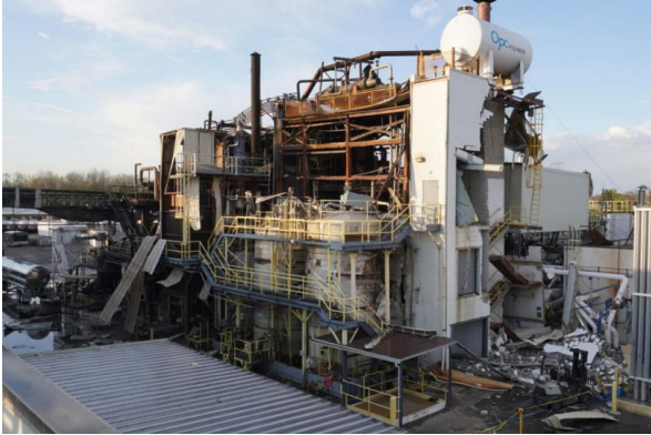
Abb.1: Explosion in Produktionsanlage (Quelle: U.S. Chemical Safety Board)
