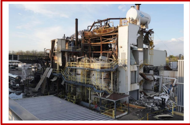
1. ábra: A polimer-épület a bent történt robbanás után (Forrás: CSB eseményjelentés, No. 2021-04-I-OH)
