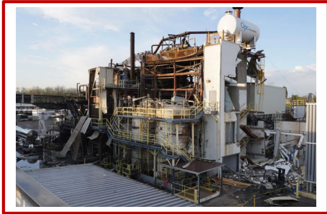
Figura 1. L'impianto di produzione della resina dopo l'esplosione interna (Source: CSB report No. 2021-04-I-OH)
