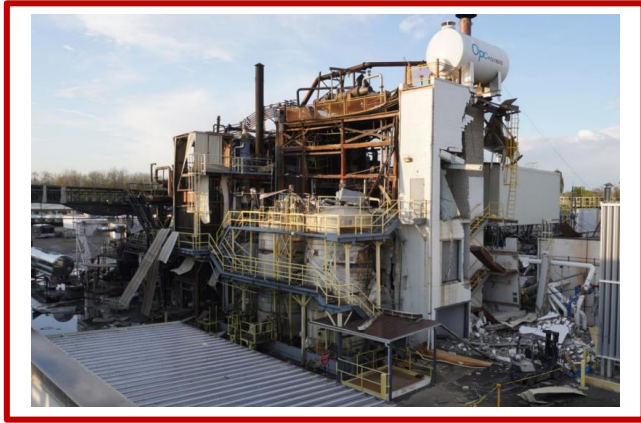
Figura 1. Clădirea după explozie
