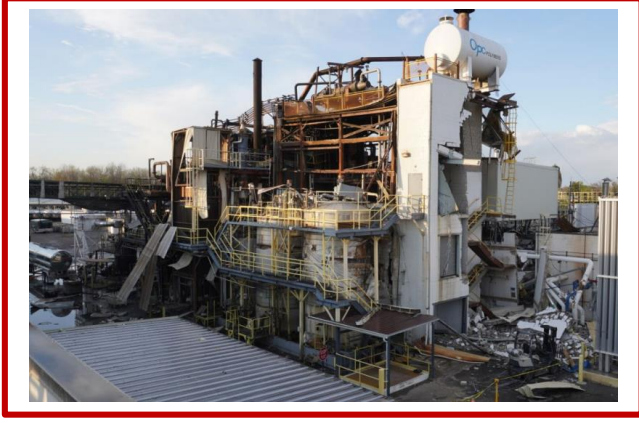
Figure 1. உட்புற வெடிப்புக்குப் பிறகு பிசின் கட்டிடம் (Source: CSB report No. 2021-04-I-OH)
