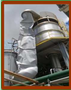
Abb. 1: Trockner- eingang, vom Vakuum zusammen- gezogen
