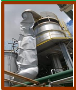
Fig. 1: Inloppska- nalen till en torkare kollapsad på grund av vakuüm
