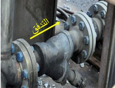
**الشكل 1.** مصفاة على شكل حرف Y من الحديد الزهر تم تركيبها بشكل غير صحيح في خط ملحوم من الفولاذ المقاوم للصدأ.
