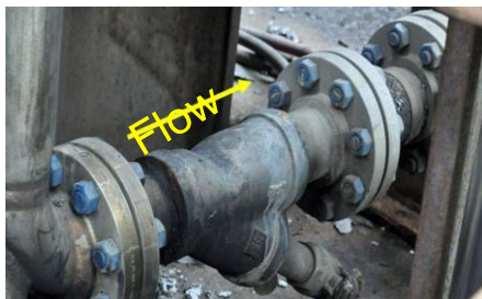
Фигура 1. Чугунен Y-образен филтър, неправилно монтиран в заварена линия от неръждаема стомана.
