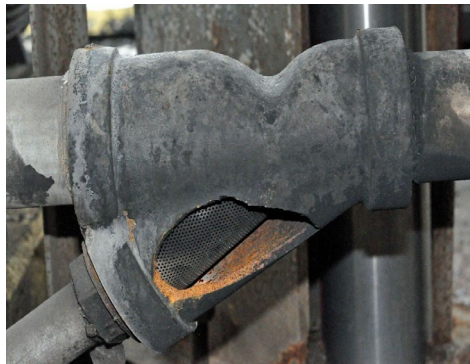
Figuur 1. Gietijzeren Y-strainer (filter) verkeerd gemonteerd in een gelaste RVS leiding.
