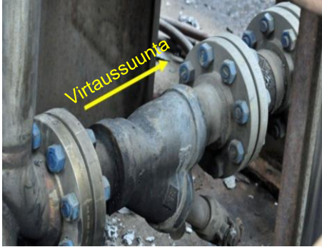
Kuva 1. Hiiliteräksinen sihti ruostumattomasta teräksestä valmistettuun putkistoon asennettuna
