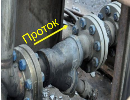
Слика 1. Неправилно поставен Y-филтер од леано железо во заварена линија од нерѓосувачки челик.
