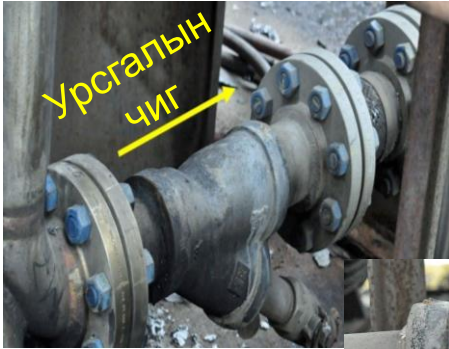
1-р зураг. Ү хэлбэрийн ширмэн шүүрийг гагнаастай ган хоолойд буруу угсарсан байдал
