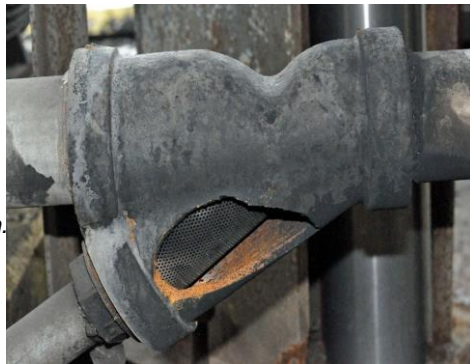
Hình 1. Bộ lọc chữ Y bằng gang được lắp đặt không phù hợp trên đường ống thép không gỉ.
