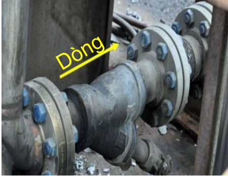
Hình 1. Bộ lọc chữ Y bằng gang được lắp đặt không phù hợp trên đường ống thép không gỉ.
