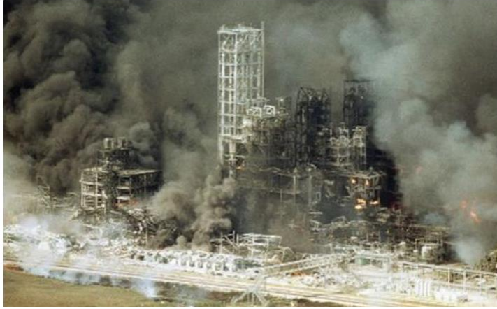
Figura 1: Gli incendi successivi alle esplosioni hanno richiesto 10 ore per essere domati (ref 1)
