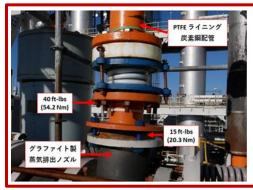
図1. 配管レイアウトと 正しい締付トルク
