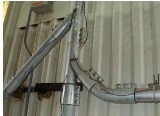
Rørledning med jordledninger
