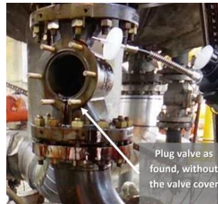
شکل ۳. نمایی از شیر پس از حادثه
