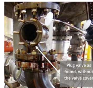
תמונה 3: שסתום אחרי האירוע Plug valve as found, without the valve cover
