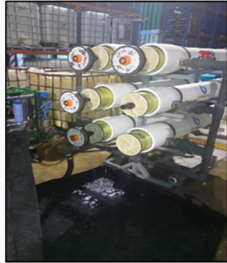
Figura N°04. Desmontaje de membranas
