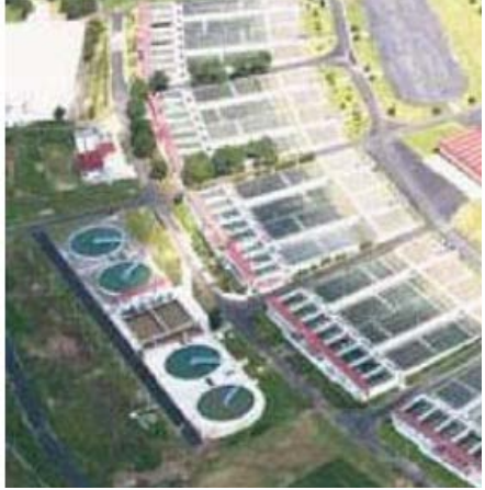
Purificación de agua y tratamiento de residuos
